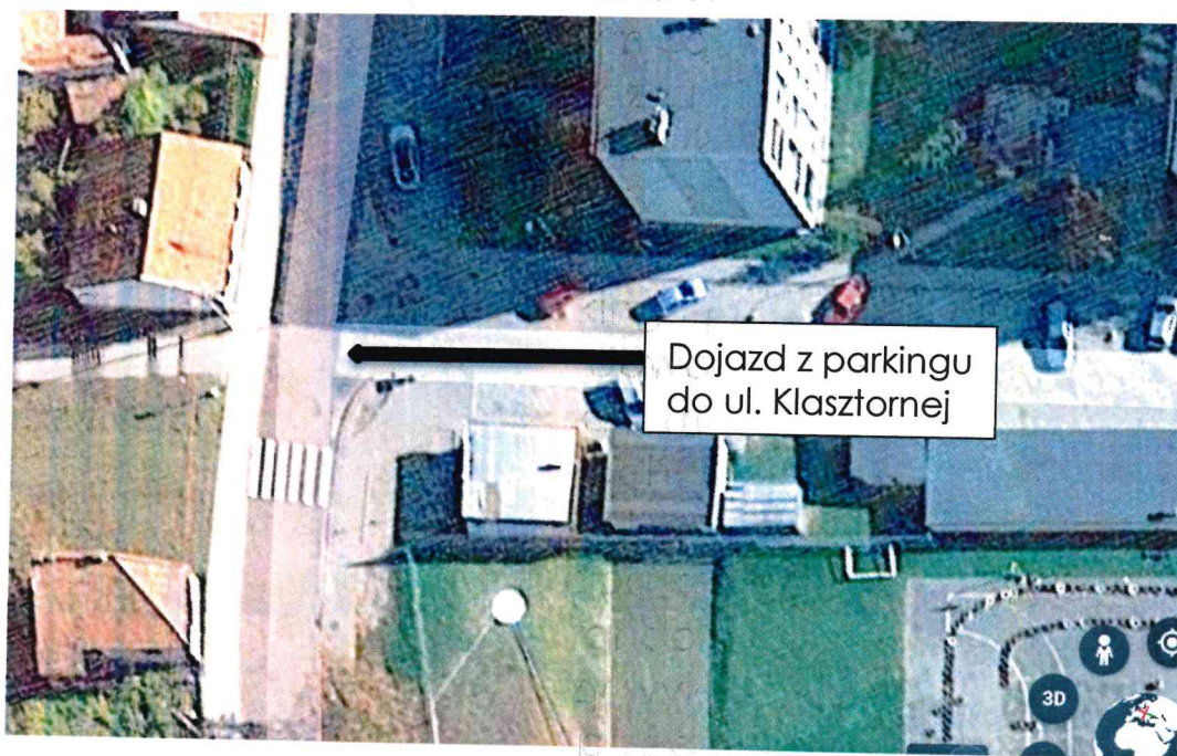
Ryc. 1 Dojazd do miejsca – włączania się do ruchu w ul. Klasztorną. W miejscu tym widoczność w ciąg ul. Klasztorną jest znacznie utrudniony, czasem wręcz niemożliwy.
